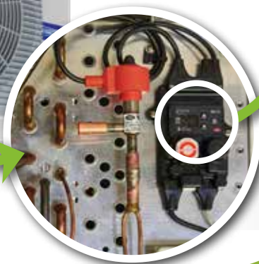
Elektroniczny zawór rozprężny i jego sterownik.
